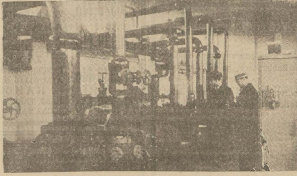
Fabrikanın havagazi tesisi satının bulunduğu kısım..
